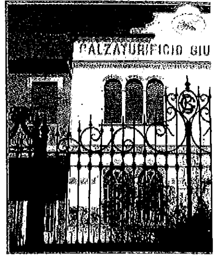
L'ex calzaturificio è avvolto dal degrado: co
